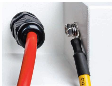
10. Conectar el cable de comunicación de 2 metros del puerto externo del BATTERY CUBE al inversor. En caso de instalar en exteriores, es necesario colocar el prensaestopas para el puerto RS485 que viene en la bolsa de accesorios para asegurar la estanqueidad.
