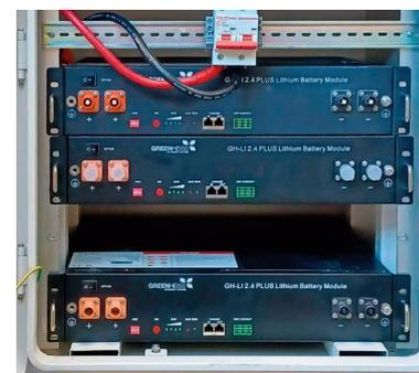
6. En el caso de tener baterías GH-LI 4,8 BLACK, atornillar las baterías al armario utilizando los tornillos M5 que vienen incluidos.
